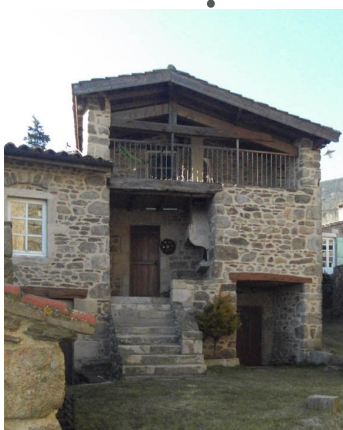
Exemple de débord de toiture
