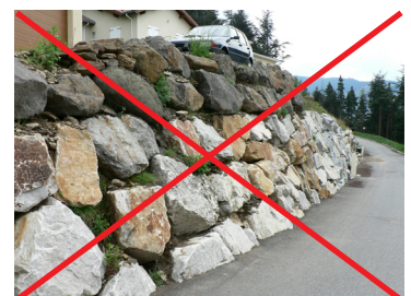
Exemple d'enrochements de type cyclopéen
