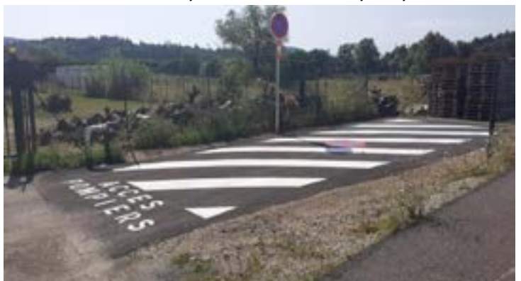
Emplacement de la nouvelle défense incendie pour la zone d'activité du Grand Pré.
