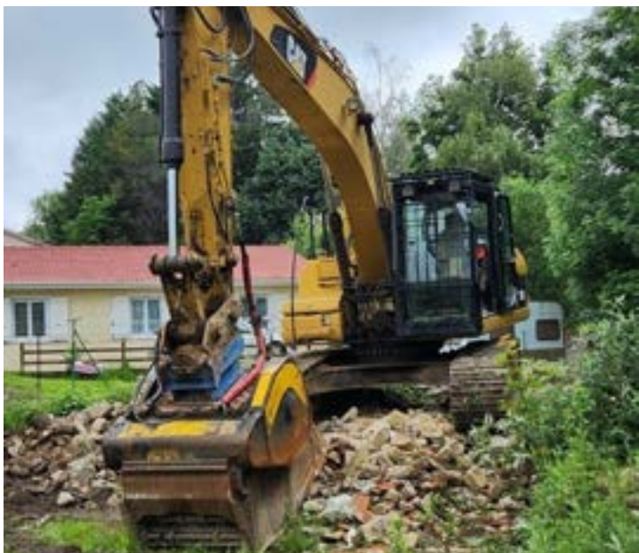
Pelle mécanique avec un godet concasseur sur le site
