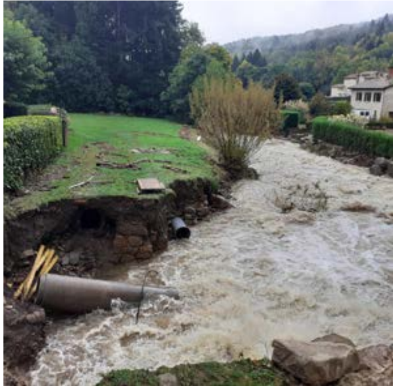
Pont du moulin
