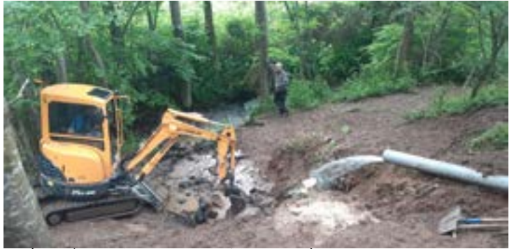
Remise en état des berges du cours d'eau Les Pontins
