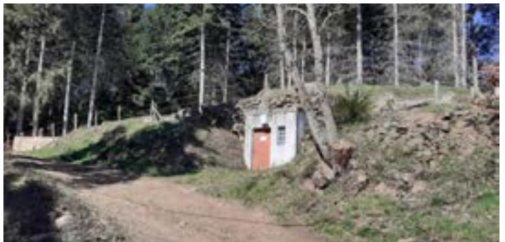
Mise en conformité du réservoir d'eau potable de la Miellerie
