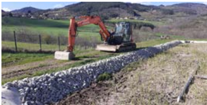
Rénovation de la bâche des bassins de la station phytoépuration
