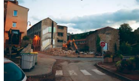
Le 3 octobre après démolition.
