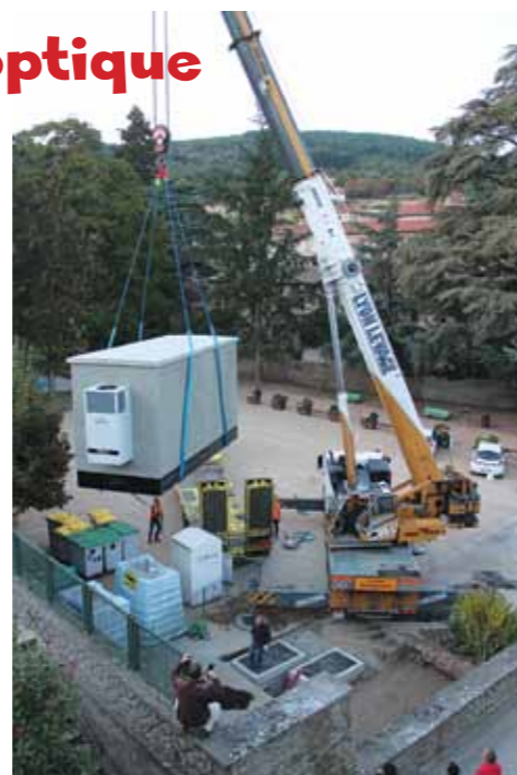
▲ Dépose du local technique (26 tonnes). ▼ Élargissement du lit de la rivière.
