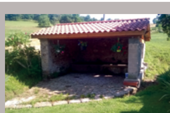
Le lavoir-abreuvoir de Liponne terminé et fleuri à l'initiative des riverains.
