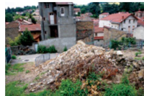
Démolition montée Saint-Ennemond
